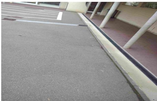
Durant la période estivale, une sécurisation de la cour de l'école a été réalisée par une mise à niveau et la pose d'un caniveau raccordé au réseau pluvial.
